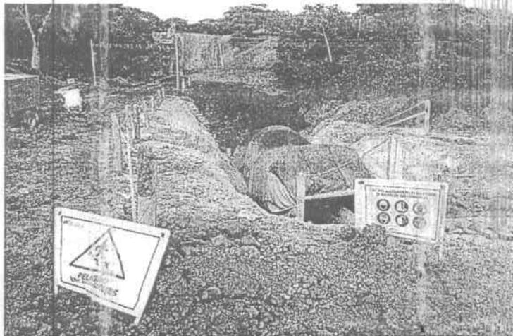
Fotografía No. 2 instalación de un tramo de 15 metros de tubería –con señales informativas y de seguridad
